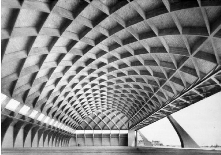
Figuur: Vliegtuighangaar opgebouwd uit spanten en gekromde panelen.
