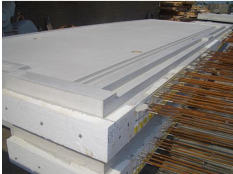
Figuur 2-7 Prefab Betonnen balkon platen klaar voor installatie, zichtbaar zijn de uitstekende wapeningsstaven van de koudebrug onderbrekende verbinding.
