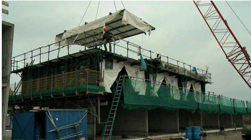
Figuur 3-1 het gebruik van tunnelbekistingen bij de bouw van rijtjeshuizen, aan de kraan is de isolerende afdekking van de bovenzijde zichtbaar
