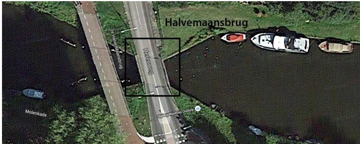
FIGUUR 1.1 BOVENAANZICHT VAN DE HALVEMAANSBRUG. BRON: GOOGLE MAPS
