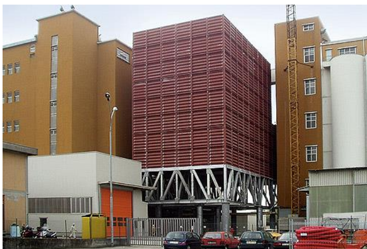
Figuur 40 Foto van de profielwandsilo met een plaathoogte van 24 meter. (PETKUS, 2017)
