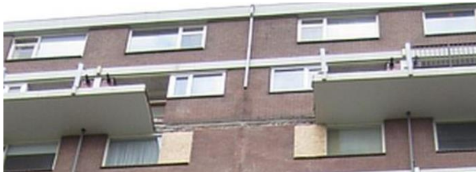
Figuur 2.7 Ingestorte galerijplaat van de Antillenflat.
