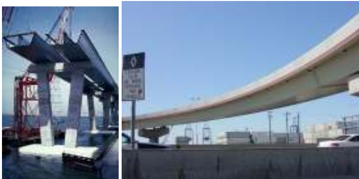
Figuur 10: voorbeeld kokerligger toegepast in brugconstructies
