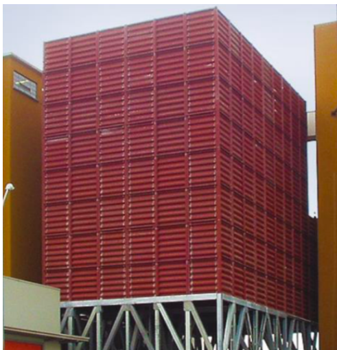
Figuur 37 - Afbeelding van een silo
