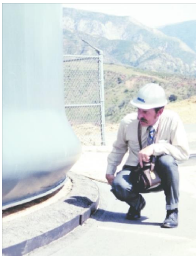
Afbeelding 5. 'Olifanten voet' knikvorm (Malhotra)
