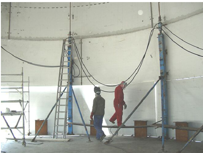
Figuur 4.11 - Montage reactorwand
