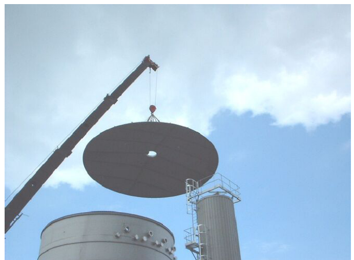
Figuur 4.12 - Plaatsing reactordak
