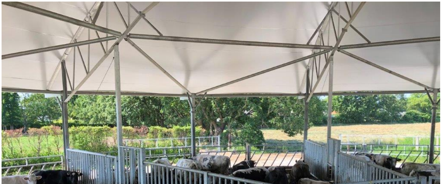
Figuur 11: Binnenste kolommen en verbindingen van The Roundhouse 30. Geraadpleegd van "ID Agro", gemaakt door ID Agro BV, 2020 ( https://www.idagro.nl/projecten/agrarisch/the-roundhouse/roundhouse-30-voor-belgisch-witblauw ).
