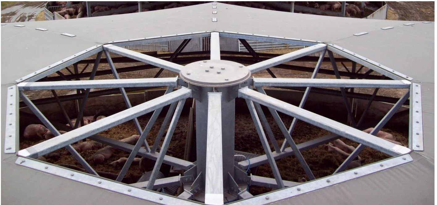
Figuur 17: Aansluiting van het doek op de vakwerkspanten. Geraadpleegd van "ID Agro", door ID Agro BV, 2016 ( https://www.idagro.nl/producten/the-roundhouse ).
