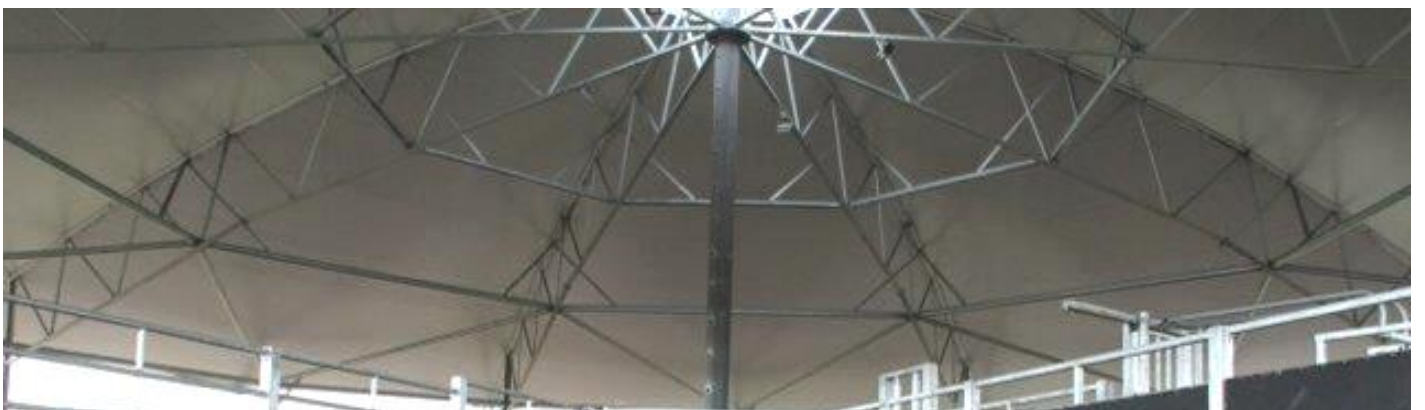
Figuur 14: Vakwerkspant van The Roundhouse 30. Geraadpleegd van "ID Agro", gemaakt door ID Agro BV, 2020 ( https://www.idagro.nl/projecten/agrarisch/the-roundhouse/roundhouse-voor-zoogkoe-tot-vleesstier ).
