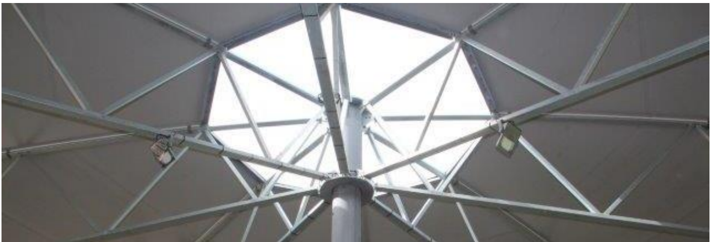
Figuur 13: Verbinding vakwerkspant aan centrale kolom. Geraadpleegd van "ID Agro", gemaakt door ID Agro BV, 2020 ( https://www.idagro.nl/projecten/agrarisch/the-roundhouse/roundhouse-voor-zoogkoe-tot-vleesstier ).
