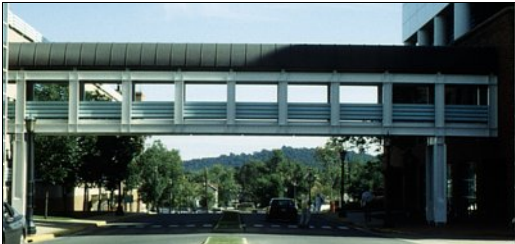
Figuur 15 Vierendeelligger als draagconstructie loopbrug
