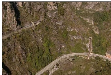
afbeelding 2. Het 38 meter hoge “Viaduc de Scarassoui”. Aanvankelijk bestaande uit gemetselde bogen en na de gehele verwoesting in 1922 pas in 1978 herbouwd (uitvoer: volledig in gewapend beton). Met zijn 125 meter lengte wordt er een horizontale hoekverdraaiing van 9° gerealiseerd, waarbij de as, op de helft van het traject tussen de twee kolommen, 1.80 meter uit het midden ligt.
