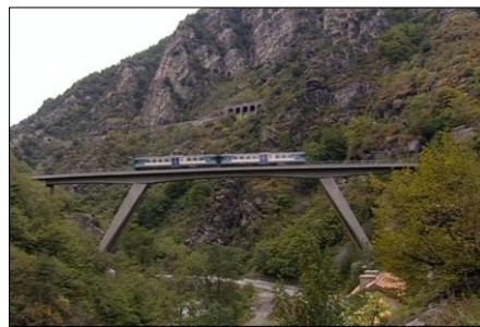
afbeelding 2. Het 38 meter hoge “Viaduc de Scarassoui”. Aanvankelijk bestaande uit gemetselde bogen en na de gehele verwoesting in 1922 pas in 1978 herbouwd (uitvoer: volledig in gewapend beton). Met zijn 125 meter lengte wordt er een horizontale hoekverdraaiing van 9° gerealiseerd, waarbij de as, op de helft van het traject tussen de twee kolommen, 1.80 meter uit het midden ligt.
