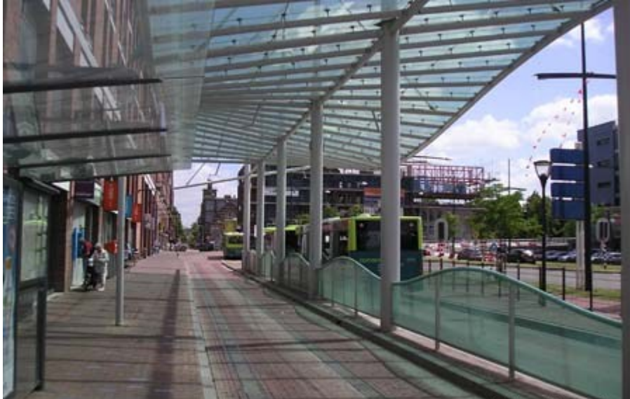
Overkapping in Delft bestaande uit getordeerde glazen platen
